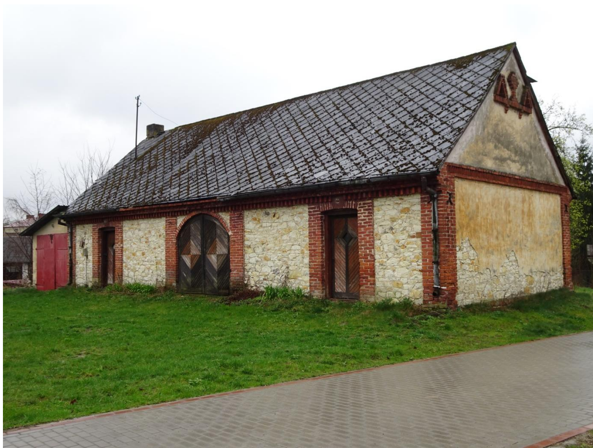
Zdjęcie 6. Budynek zabytkowej remizy strażackiej w Rogowie.
